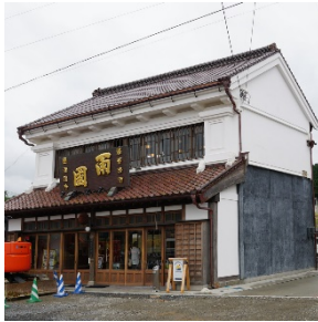
角星店舗：1階は津波で損壊。2階は押し流されたが残置されたのを曳家し調査全解体再建
