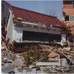
角星店舗：1階は津波で損壊。2階は押し流されたが残置されたのを曳家し調査全解体再建
